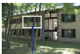
Situation dans le bâtiment
