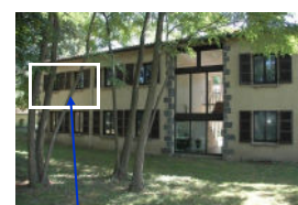
Situation dans le bâtiment
